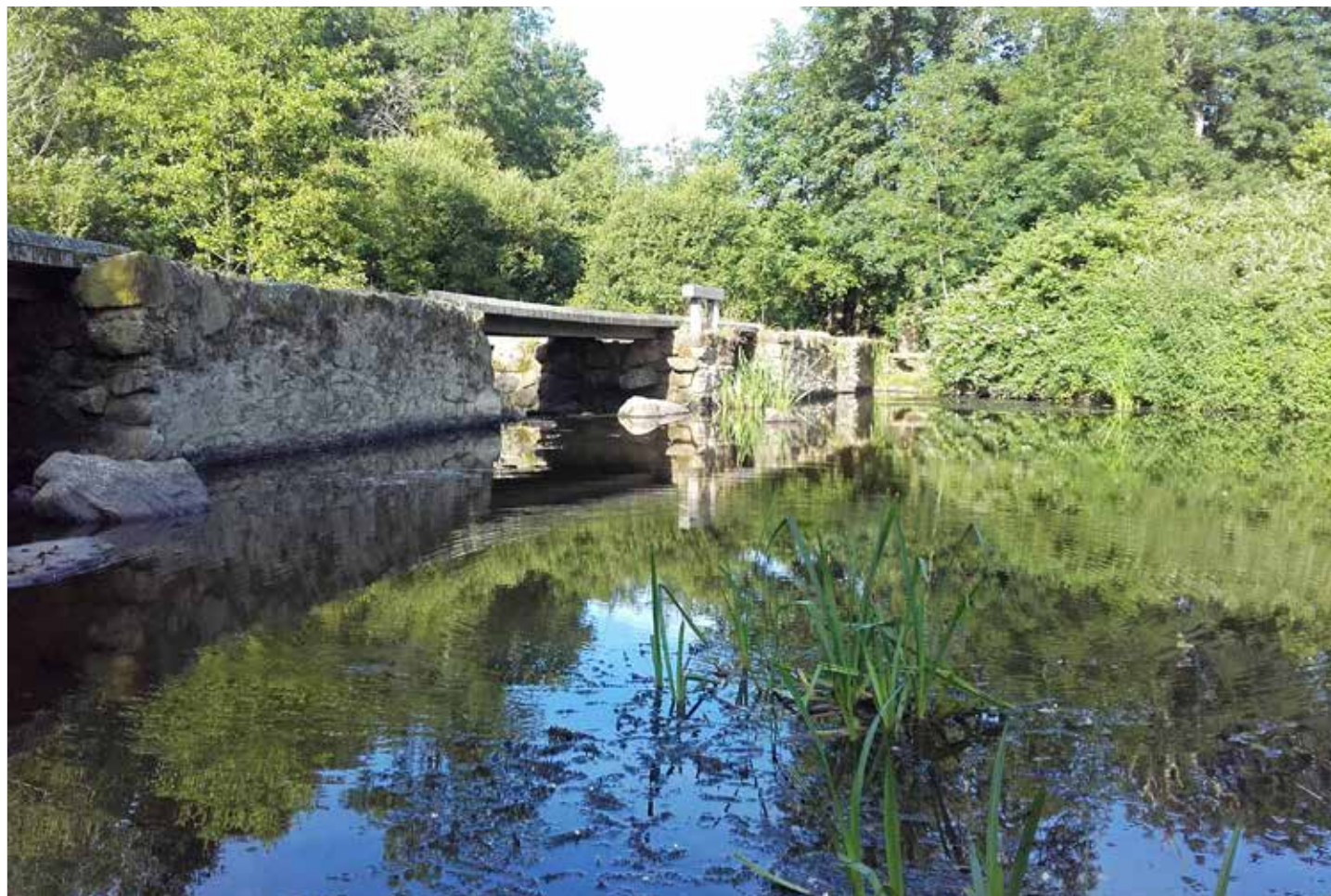
L'ouvrage de Chavagnes au sud de l'agglomération.
