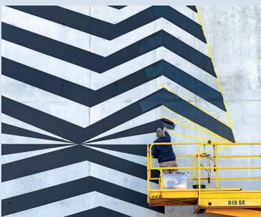
Réalisation par l'entreprise Boscher
